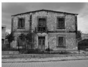
Ασυντήρητη και εγκαταλελειμμένη οικοδομή
