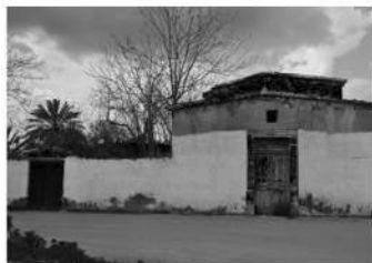
Ασυντήρητη και εγκαταλελειμμένη οικοδομή
